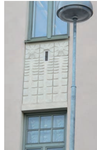
Pääjulkisivu ja sen jugendkoristeet ovat säilyneet.
